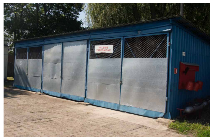
WIATA MAGAZYNOWA Z SIATKI STALOWEJ 7
