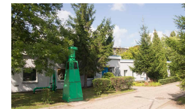
BUDYNEK BYŁEGO TABORU PŁYWAJĄCEGO 14
